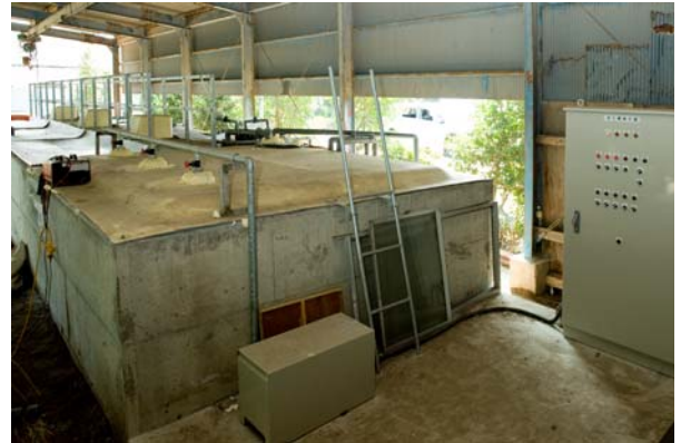
《既存地下式角形サイロを再利用した浄化槽》
