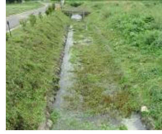
(きれいになった作業後の水路)
