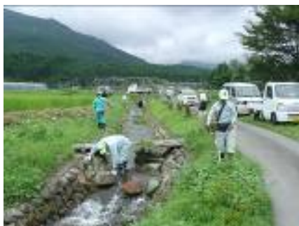
(水路内及び土手の草刈り作業)
